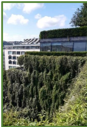
Abbildung 18: Calwer Passage Fassade [5]
