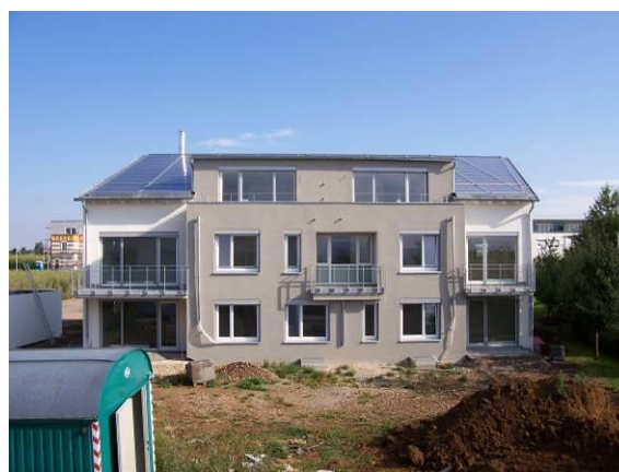
Bild 234 Vorder- und Rückansicht Mehrfamilienhaus mit Heizzentrale und Kollektorfeld
