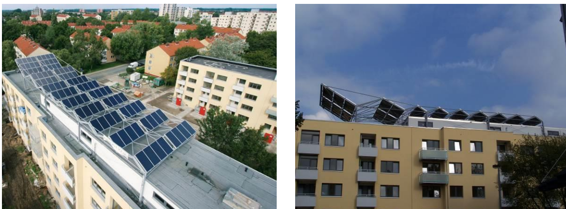
Bild 251 Links: Dachaufsicht mit Kollektoranlage [Quelle: www.corona-solar.de ], Rechts: Westansicht Gebäude Magdeburger Straße 2 mit Kollektorfeld
