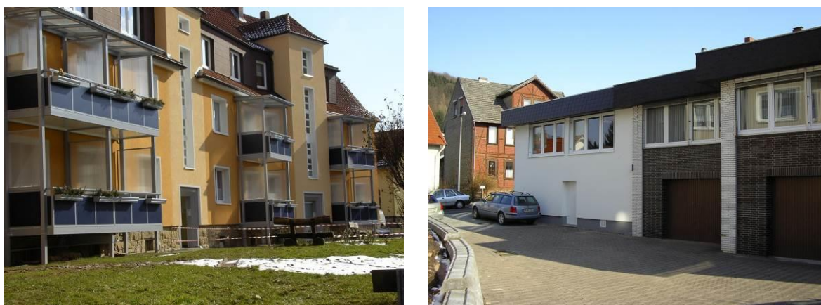
Bild 154 Links: Südwest-Ansicht Mehrfamilienhaus, Rechts: Südwest-Ansicht Verwaltungsgebäude Wiershäuser Weg Hannoversch-Münden
