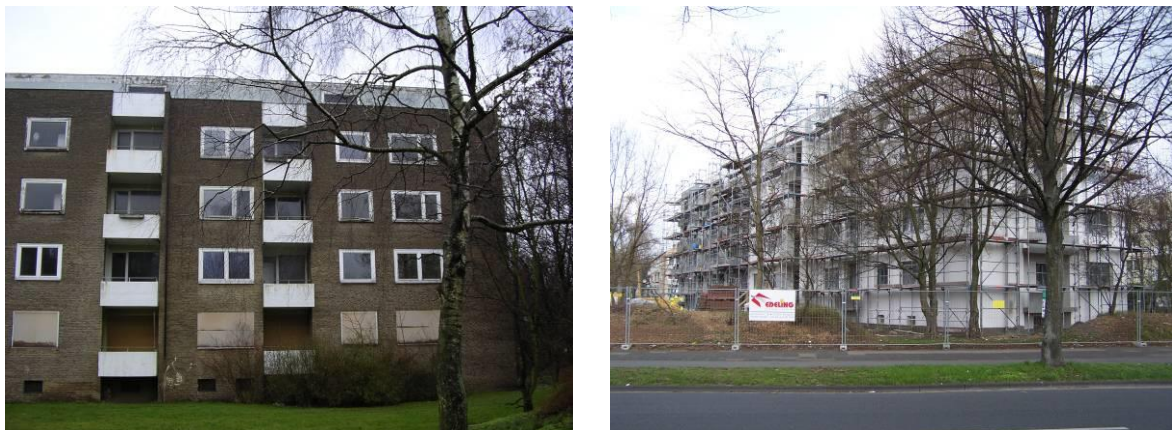
Bild 145 Links: West-Ansicht Gebäude unsaniert Magdeburger Str. 2, Rechts: Südwest-Ansicht während der Sanierung Magdeburger Str. 4
