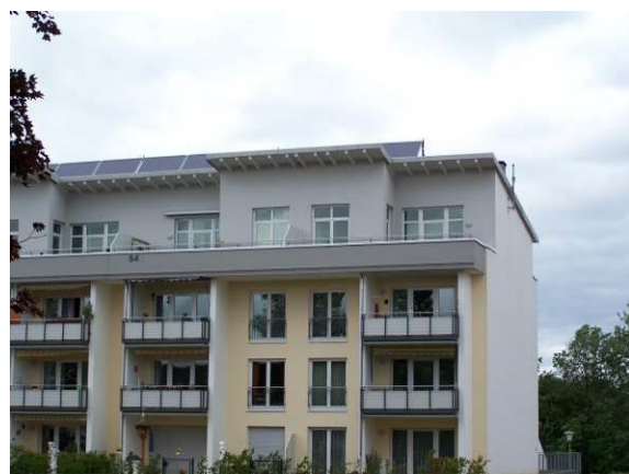
Bild 262 Kollektoranlage auf dem nach Norden geneigten Pultdach Brentanostraße 54-56
