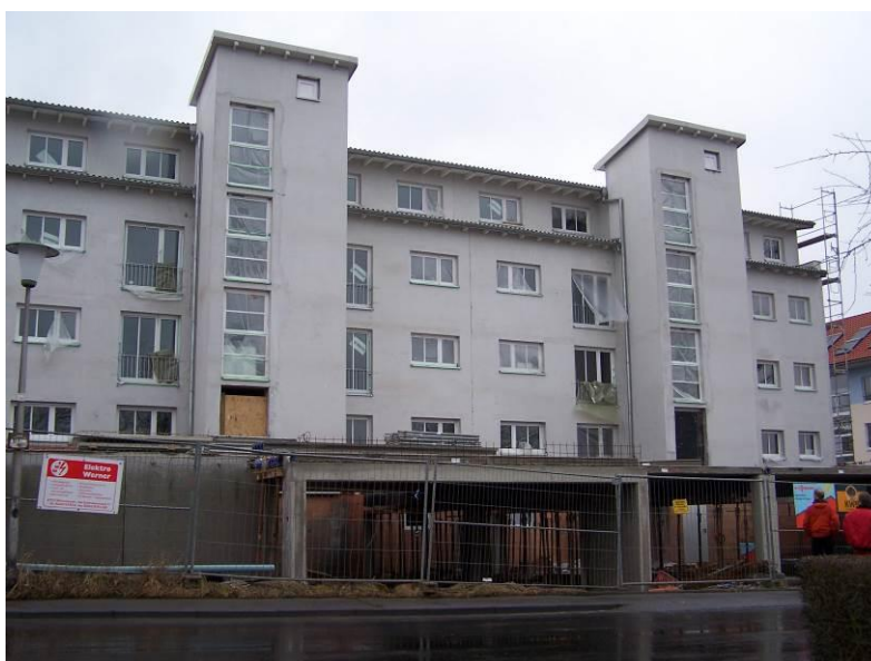
Bild 195 Fotografische Aufnahme des Rohbaus, Brentanostraße 54-56, Kassel.
