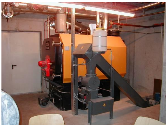
Bild 222 Links: Holzpelletkessel in Heizzentrale Rechts: Kollektorfeld auf Garagendach
