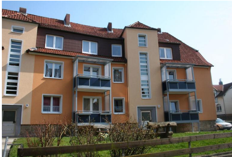
Bild 196 Westansicht des Mehrfamilienhauses WW 35-41
