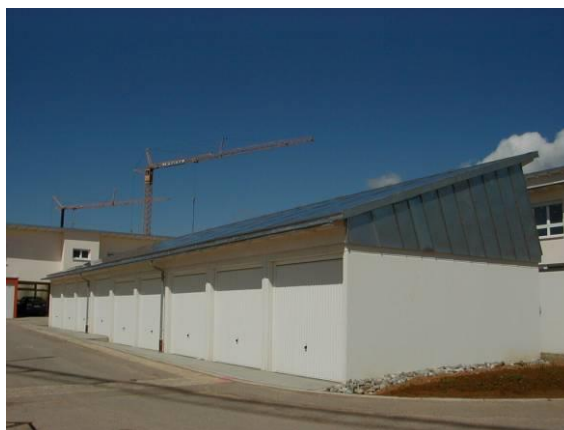
Bild 222 Links: Holzpelletkessel in Heizzentrale Rechts: Kollektorfeld auf Garagendach
