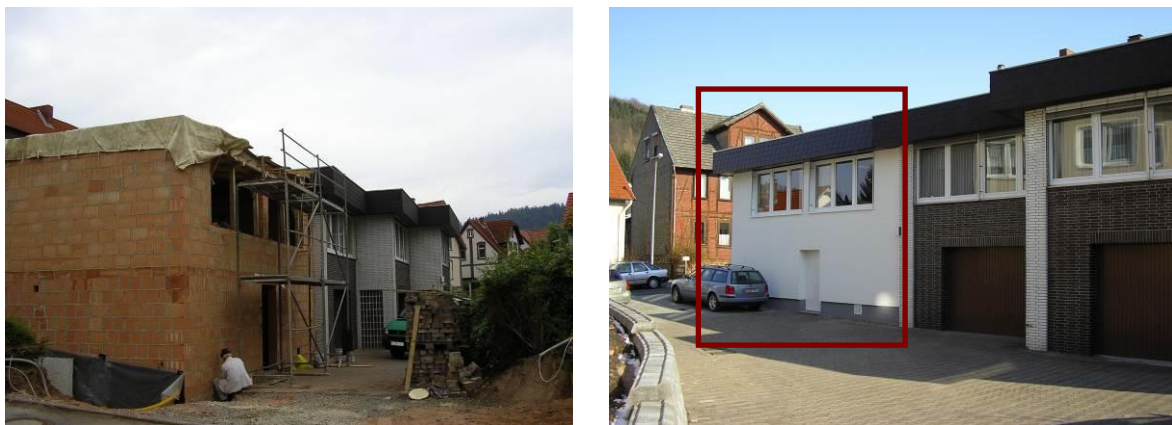
Bild 254 Anbau an das Verwaltungsgebäude Wiershäuser Weg 27
