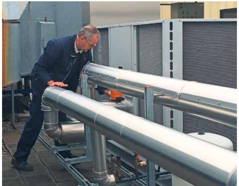
Abbildung 2: Prüfung des Ventils durch den Projektleiter
