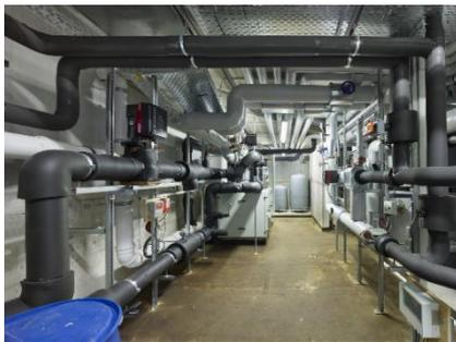
**Heizungszentrale mit Erdwärmepumpe und detaillierter Erfassung von Messdaten für ein ausführliches technisches Monitoring**
