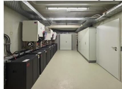
**Lithium-Eisen-Phosphat-Stromspeicher zur Zwischenspeicherung von Spitzenerträgen**
