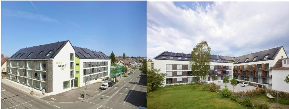
**Außenansichten campoV – Vollbelegung der Dachflächen in allen Himmelsrichtungen mit PV-Modulen, © Roland Halbe**
