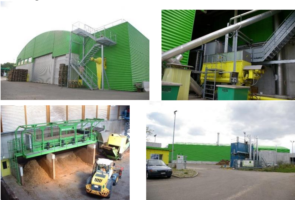
Abbildung 96: Biogasanlage-Beispiel 2 Quelle: Biogasanlage Pratteln
