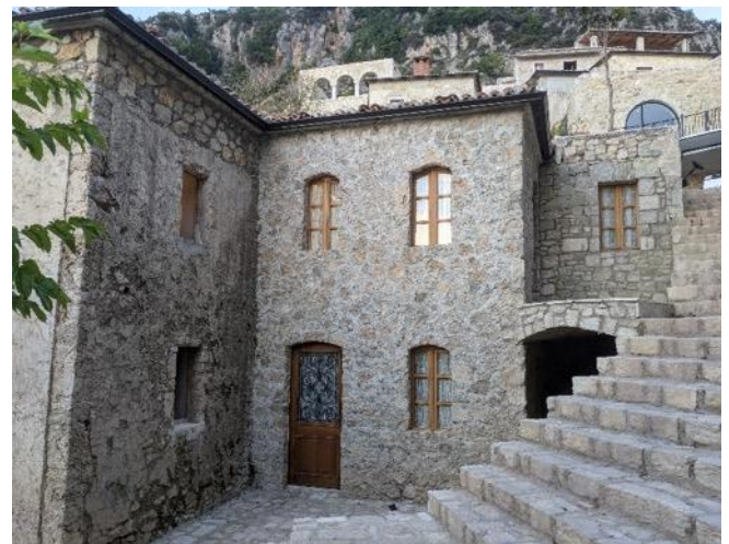
Abbildung 11 Neubau im Altbaustil Quelle: siz energieplus
