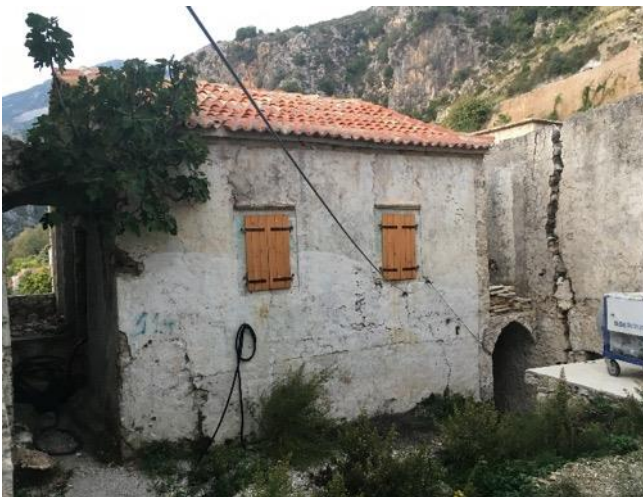
Abbildung 10 Altbauruine (in Sanierung) Quelle: siz energieplus
