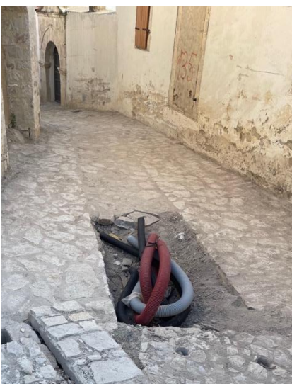
Abbildung 74: Unterirdische Leitungen in Dhermi Quelle: Goduni International GmbH, Mai 2018
