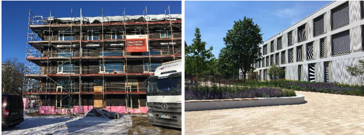
Abbildung 30: Darstellung der Fassade in 2017 (links) und 2019 (rechts)
