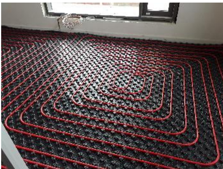
Abbildung 37: Fußbodenheizung
