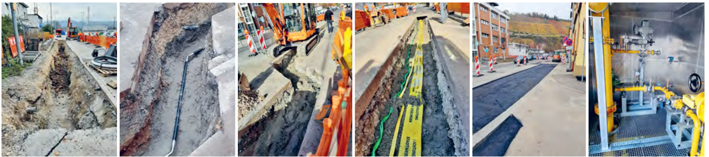
Straßensperrung und Aufbruch
