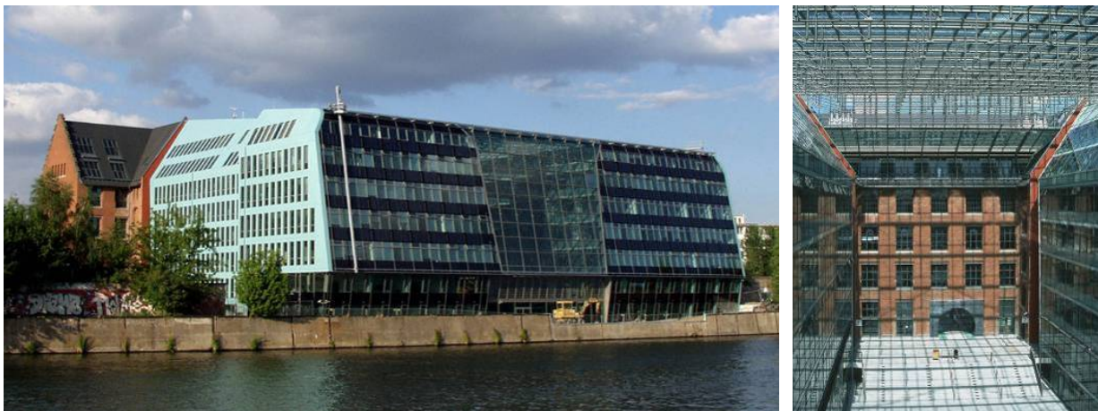
Abbildung 14: EnergieForum, Berlin – Südansicht und Blick ins Atrium vom Spreeufer [Quelle: IGS]
