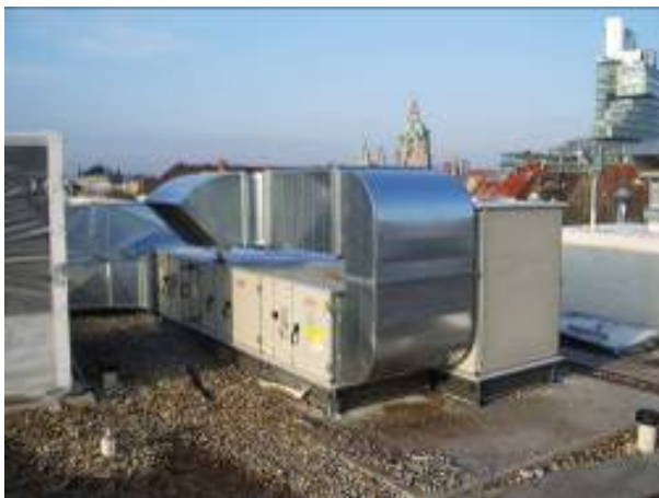
Abbildung 64 Lüftungsanlage auf dem Dach für WCs und Nebenräume, Differenzdruckmessung zur Einregulierung bei der Inbetriebnahme
