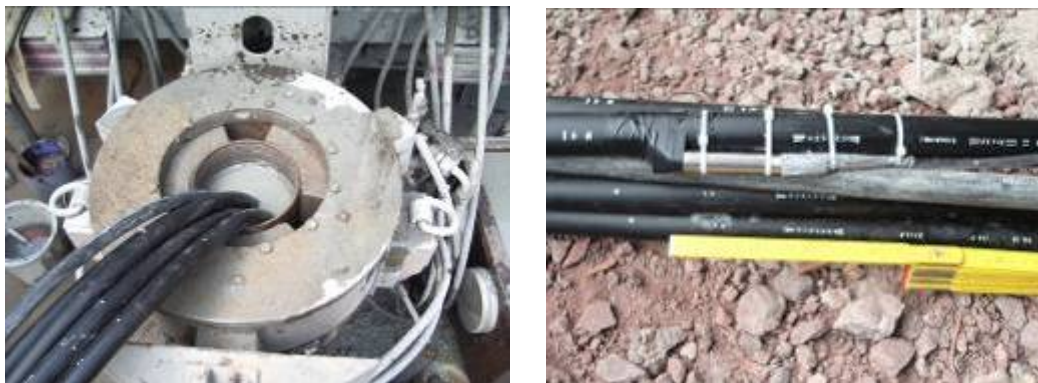
Abbildung 50 Einbringung der Erdsonden, Temperatursensor an einer Sonde
