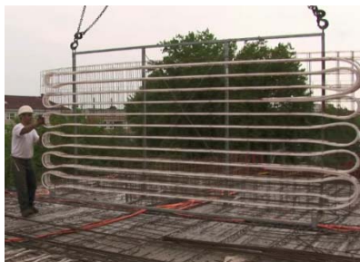
Installation der Betonkern- aktivierung
