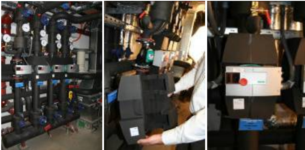
Abbildung 52 Kältesammler mit geregelten Pumpen in vorgeformten Dämmschalen
