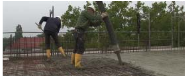
Abbildung 55 Hydraulische Verbindung der Matten, Betonage
