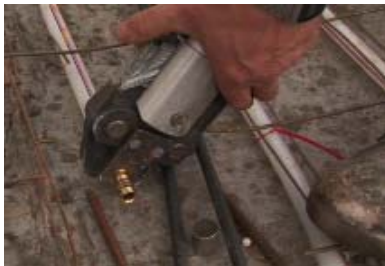
Abbildung 55 Hydraulische Verbindung der Matten, Betonage
