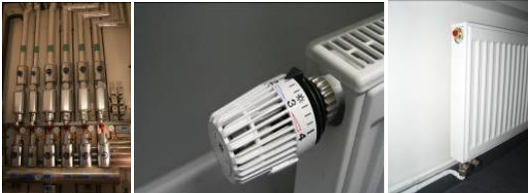
Abbildung 37 Wärmeverteiler Vorlauf, Heizkörper mit Thermostatventil, Heizkörper mit Etagenverteilungen (ungedämmt auf Putz)
