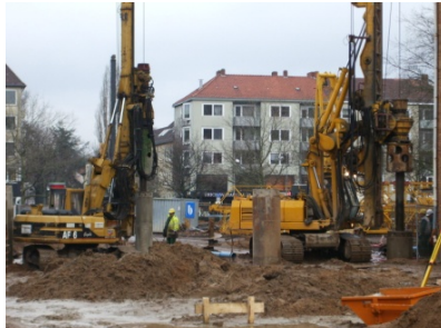
Einbringen der Pfahlgründung
