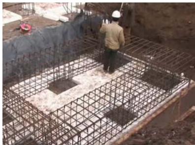
Dämmen der Bodenplatte (Aussparungen für Pfahlgründung)
