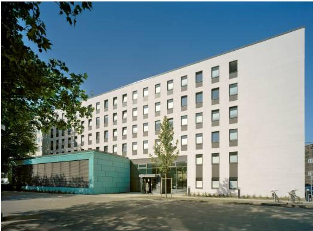
Abbildung 14 Ansicht Osten: Eingang und Saal an der Hildesheimer Straße (Foto: Bilfinger Berger)
