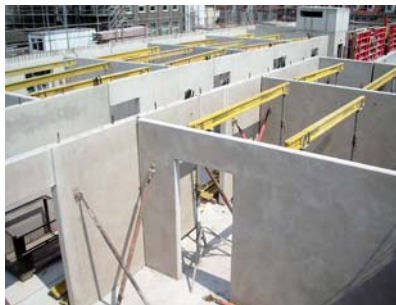
Rohbau Links: Fertigteile Rechts: Brückenbauwerk über MFB in Ortbeton
