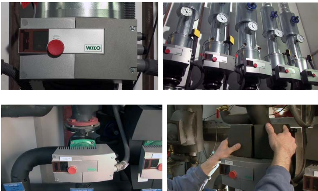
Abbildung 70 Pumpen im Heizungs- (oben) und Kälteverteiler
