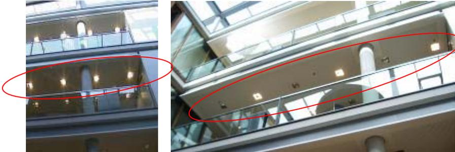
Abbildung 90 Reduzierung der installierten Beleuchtungsleistung vorher - nachher
