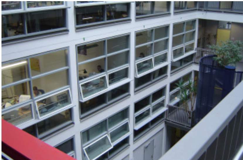
Abbildung 60 Fensterlüftungsflügel der innenliegenden Büros zum Atrium
