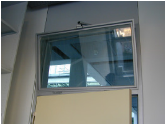
Abbildung 58 Türoberlicht zum Atrium und Raumbedienpanel
