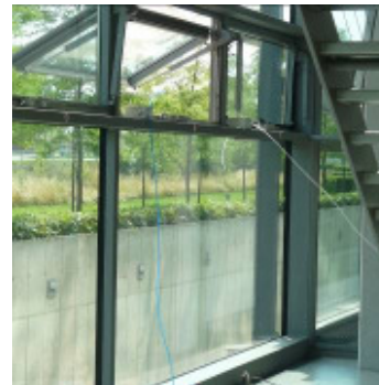
Tracergas Injektion/Druckmessung Ost
