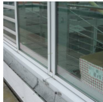
Druckmesspunkt (Bohrung im Profil)
