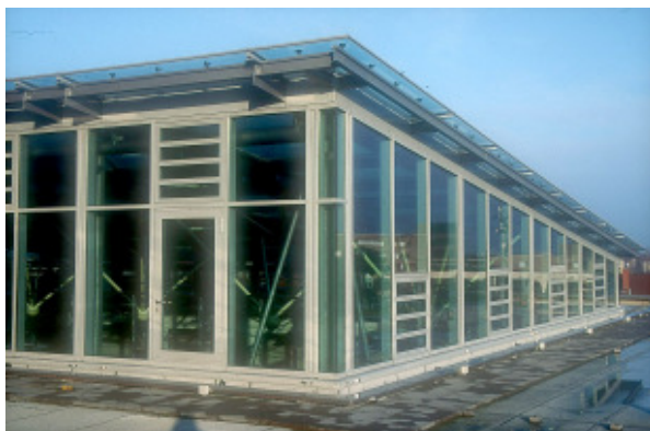
Abbildung 59 Abluftklappen im Atriumdach
