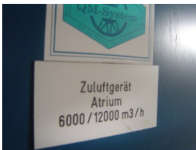
Abbildung 56 links: Austrittsöffnung mech. Lüfter; rechts: Volumenstrom
