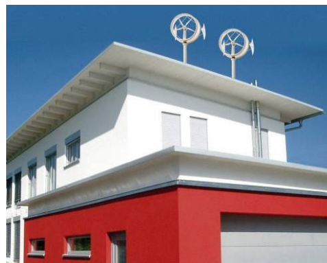
Bild 13 Links: Vertikale Kleinwindanlage VisionAIR.3 [Bildquelle: Stellaris Energy Solutions GmbH & CoKG]; Rechts: Windturbine ENFLO 0110 [Bildquelle: WindTec Systems AG]
