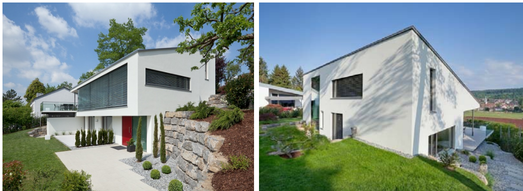
Abbildung 4: Süd-Ostansicht (links) und Nord-Westansicht (rechts)
