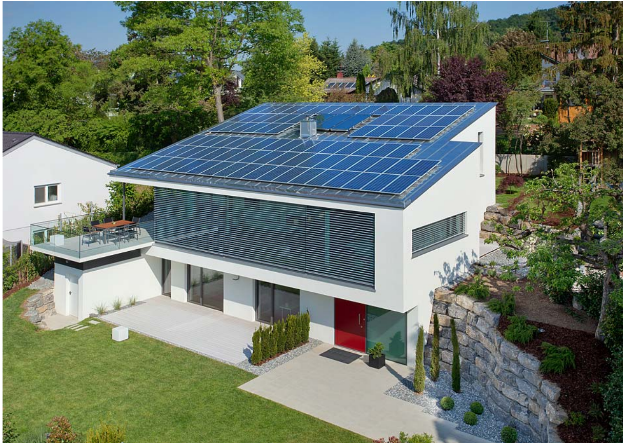
Abbildung 29: Gebäudeansicht (Südost), (Foto: Erich Spahn, Amberg)
